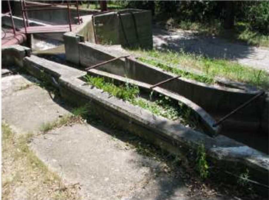
slika 20: Dovodni kanal na Aerisani peskolov – hvatač masti, deo 4
