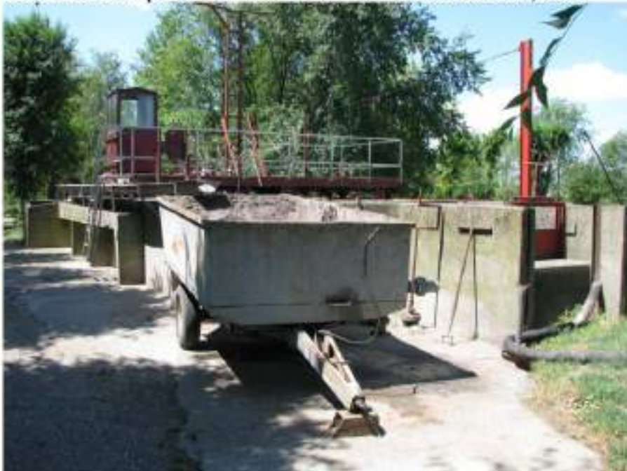
slika 24: Aerisani peskolov – hvatač masti – severoistočna strana, deo 2
