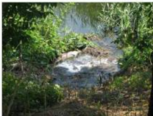
Slika br.5.: Izliv cevovoda u otvoreni kanal iz izlivne građevine
