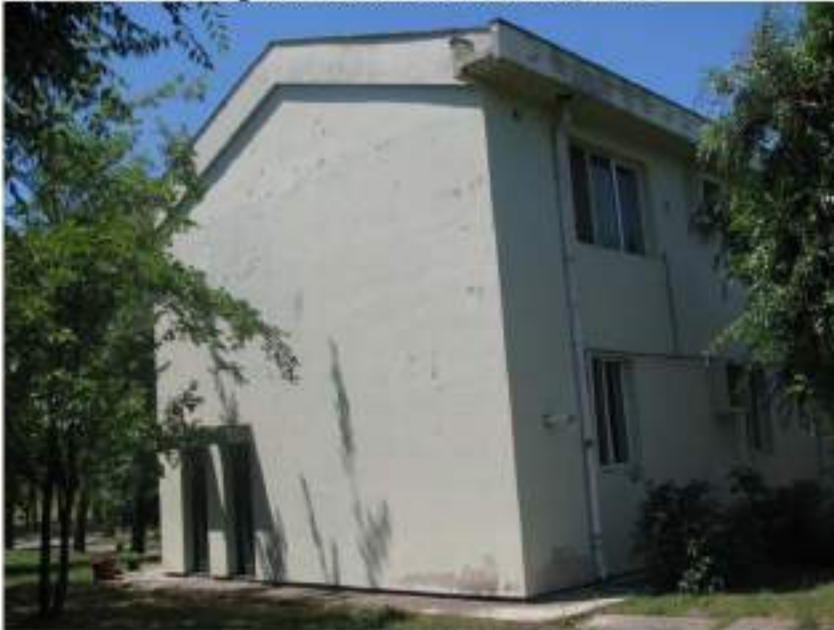
slika 4: Komandna zgrada – severoistočna fasada, deo 2
