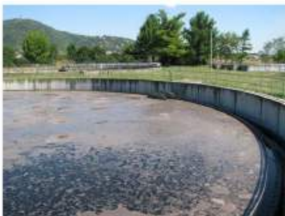
Slika br.3.: Mulj na površini naknadnog taložnika NT2
