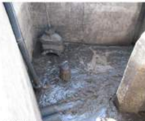
Slika br 17.: Uronjena muljna pumpa za višak mulja u usisnom delu CS za recirkulaciji
