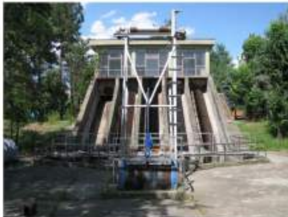
Slika br.3.: Pužne pumpe u glavnoj crpnoj stanici (ispred je gruba rešetka)
