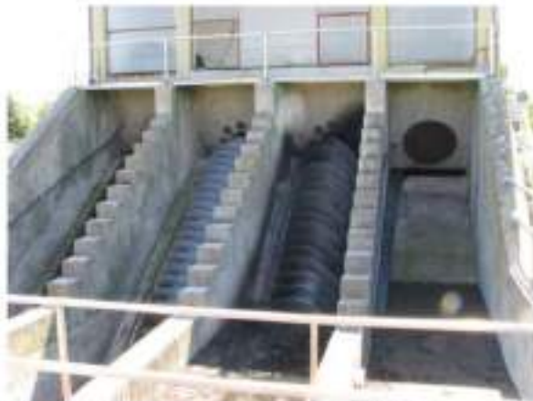
Slika br. 15.: Pužne pumpe u CS za recirkulacij
