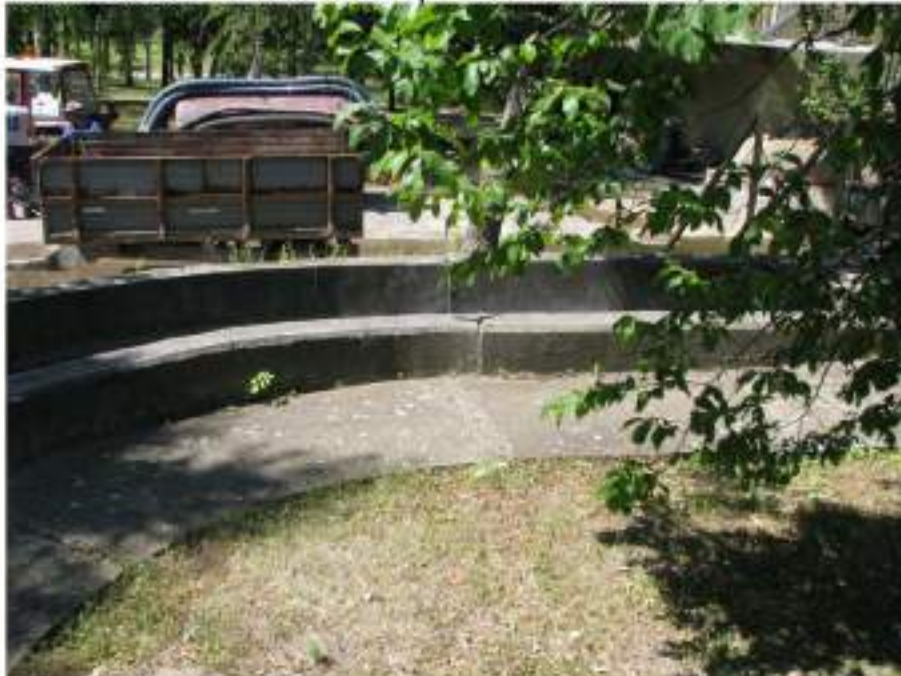
slika 18: Dovodni kanal na Aerisani peskolov – hvatač masti, deo 2
