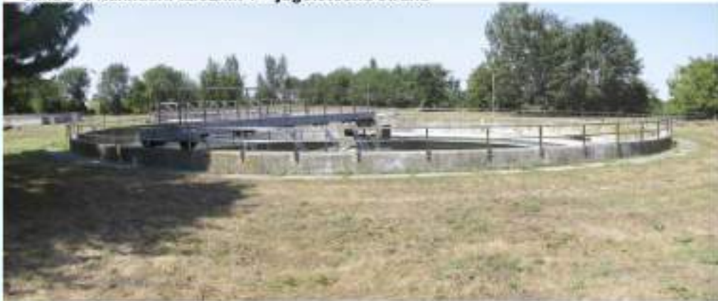
slika 54: Naknadni taložnik 1 – jugoistočna strana
