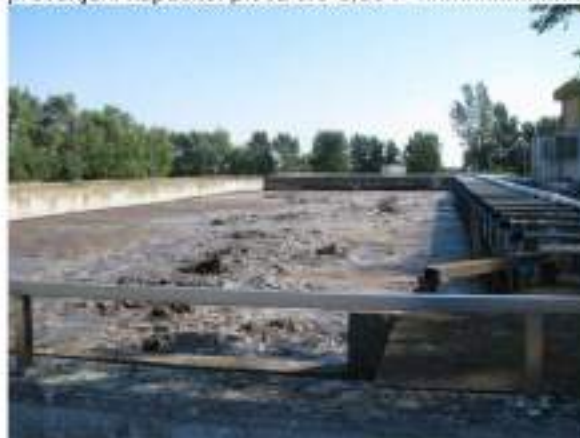
Slika br.10.: Aeracioni bazen AB2
