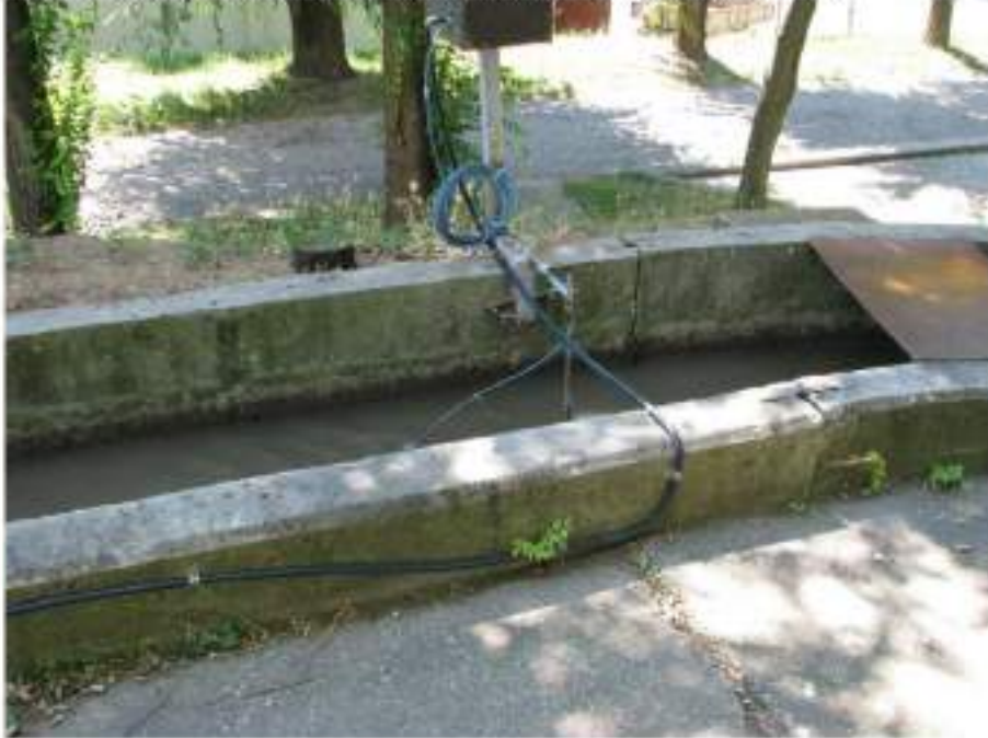
slika 20: Dovodni kanal na Aerisani peskolov – hvatač masti, deo 4
