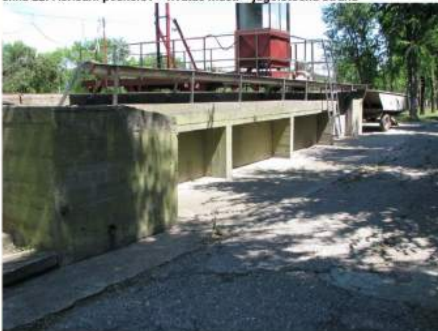
slika 22: Aerisani peskolov – hvatač masti – jugoistočna strana
