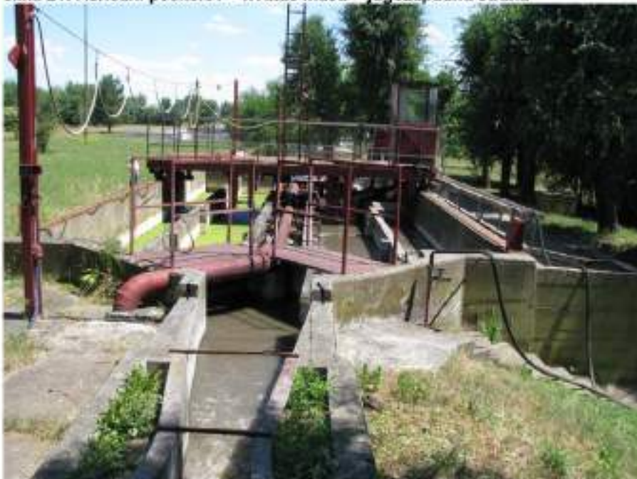
slika 22: Aerisani peskolov – hvatač masti – jugoistočna strana
