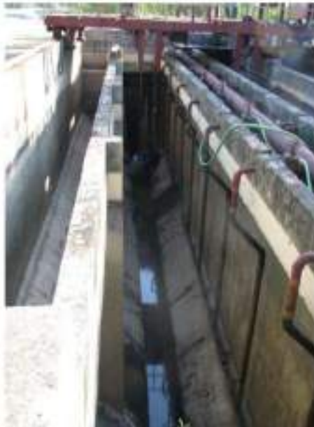
Slika br.8.: Cevovodi za aeraciju u peskolovu 2-van funkcije
