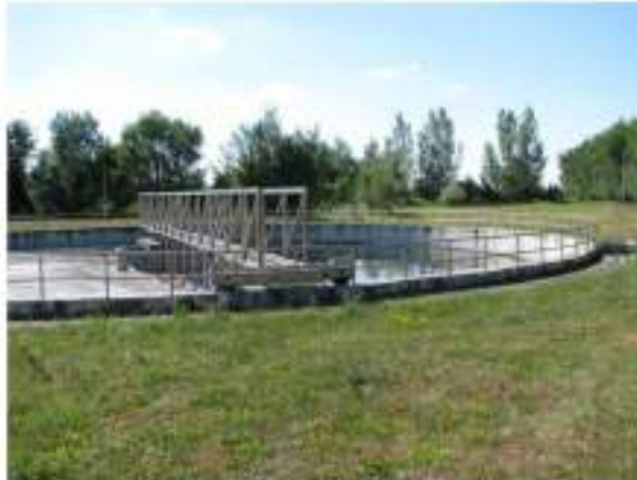
Slika br.13.: Naknadni taložnik NT2
