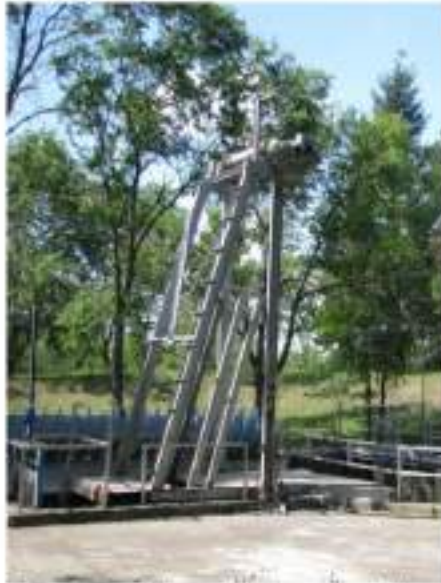
Slika br. 1.: Gruba rešetka ispred pužnih pumpi
