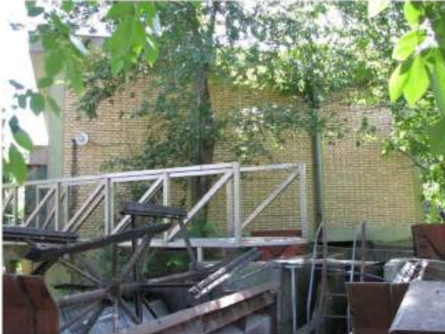
slika 10: Crpna stanica sa mehaničkom rešetkom –severoistočna fasada
