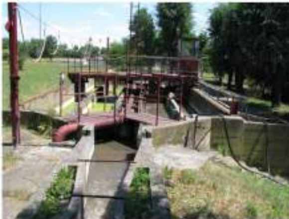
Slika br. 6.: Aerisani peskolov-hvatač masti
