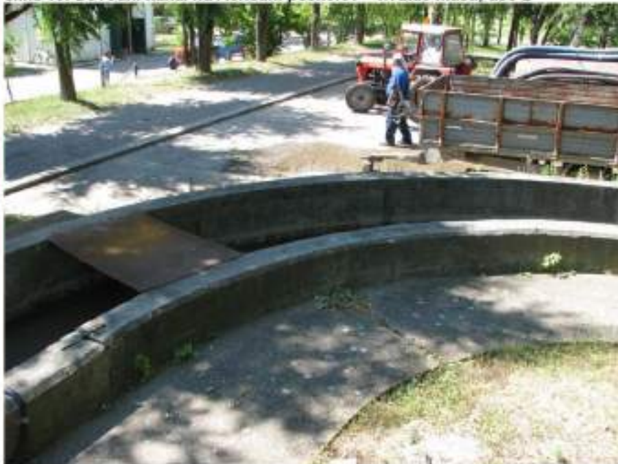
slika 18: Dovodni kanal na Aerisani peskolov – hvatač masti, deo 2
