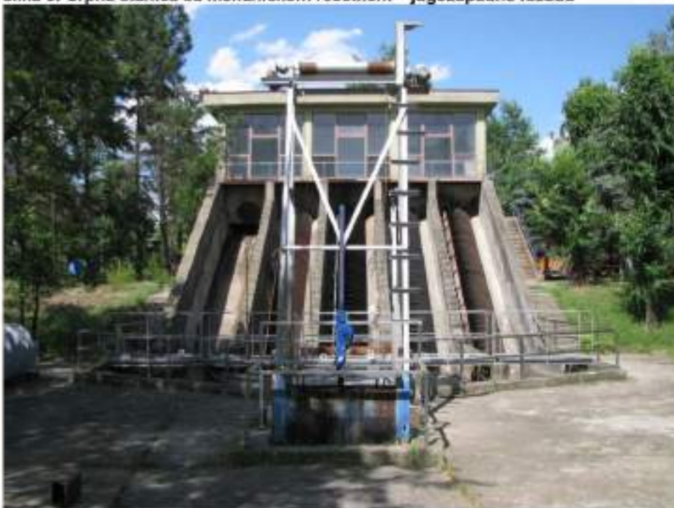
slika 6: Crpna stanica sa mehaničkom rešetkom – jugozapadna fasada
