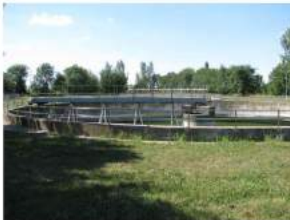
Slika br. 12.: Naknadni taložnik NT1-van funkcije
