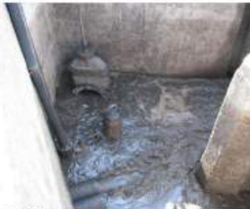
Slika br 17.: Uronjena muljna pumpa za višak mulja u usisnom delu CS za recirkulaciju
