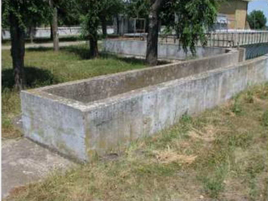
slika 34: Dovodni kanal na Aeracioni bazen 1 – južistočna strana, deo 3
