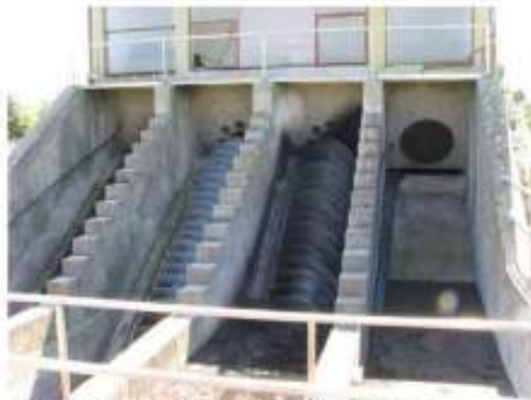
Slika br. 15.: Pužne pumpe u CS za recirkulaciju
