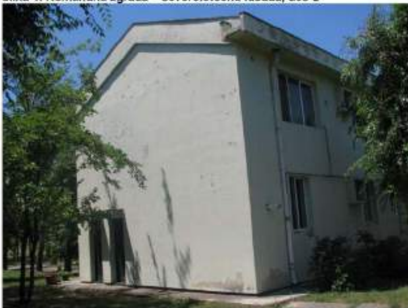
slika 4: Komandna zgrada – severoistočna fasada, deo 2
