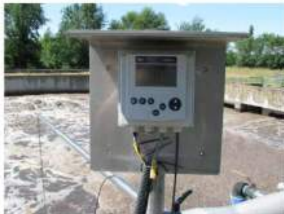
Slika br.11.: Kontrolna jedinica za merenje rastvorenog kiseonika u AB2
