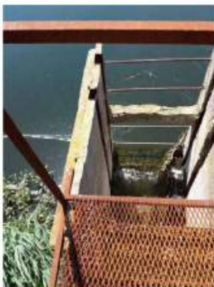
Slika br. 7.: Prelivanje vode iz lagune u izlivnu građevinu
