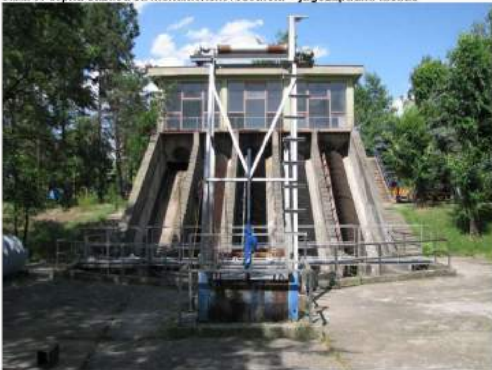
slika 6: Crpna stanica sa mehaničkom rešetkom – jugozapadna fasada
