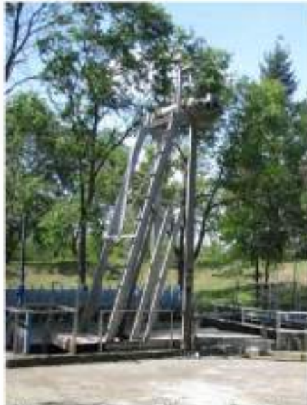
Slika br. 1.: Gruba rešetka ispred pužnih pumpi
