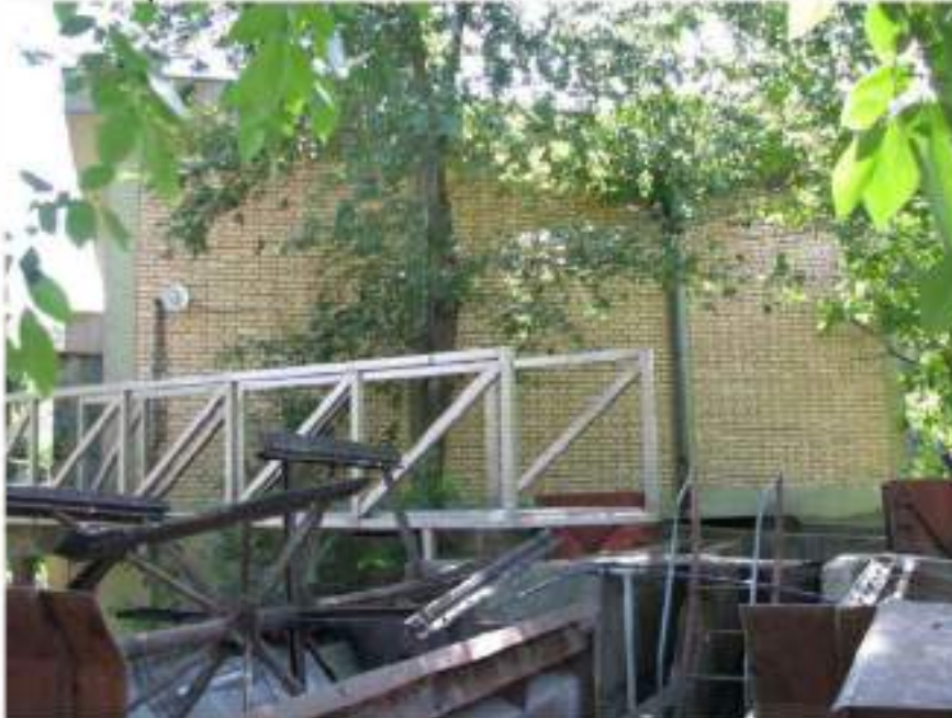
slika 10: Crpna stanica sa mehaničkom rešetkom – severoistočna fasada
