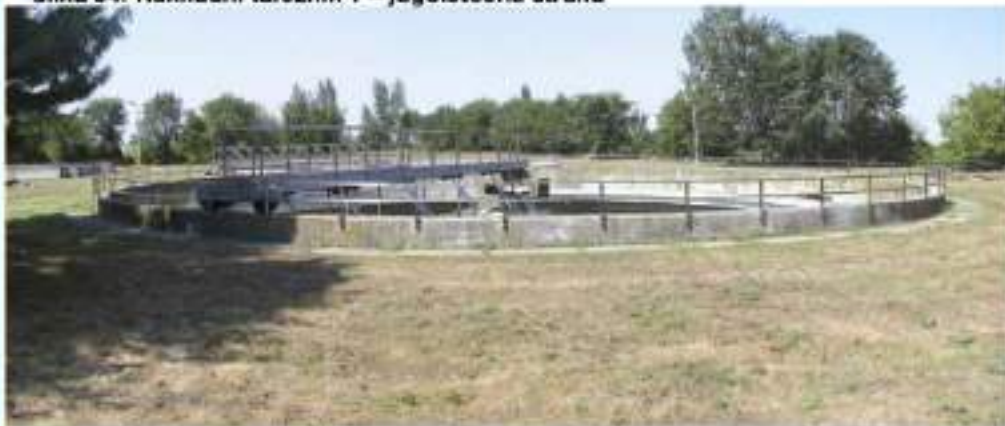
slika 54: Naknadni taložnik 1 – jugoistočna strana
