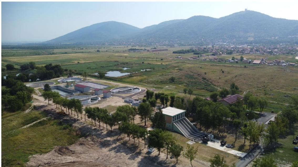
Пречишћавање отпадних вода врши се на Постројењу за прераду отпадних вода (ППОВ) које је у функцији од 1984. године. Све отпадне воде сакупљене системом санитарне канализације се, главним канализационим колектором  $\varnothing$  800, дистрибуирају до ППОВ-а, на коме је заступљена технологија биолошког пречишћавања отпадних вода.
